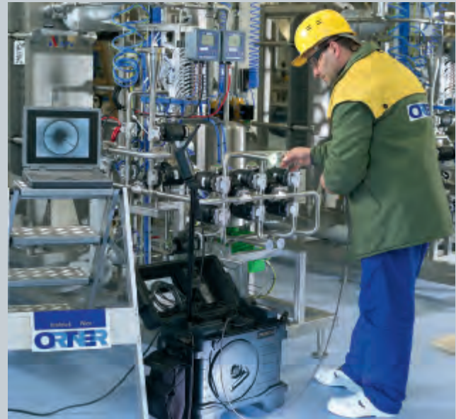
Höchste Ansprüche an die Servicetechnik: täglich 24 Stunden Bereitschaftsdienst, sieben Tage in der Woche – mit einer gut ausgebildeten, flexiblen Servicemannschaft, Logistik und Ersatzteilmanagement – und das alles kosteneffizient
