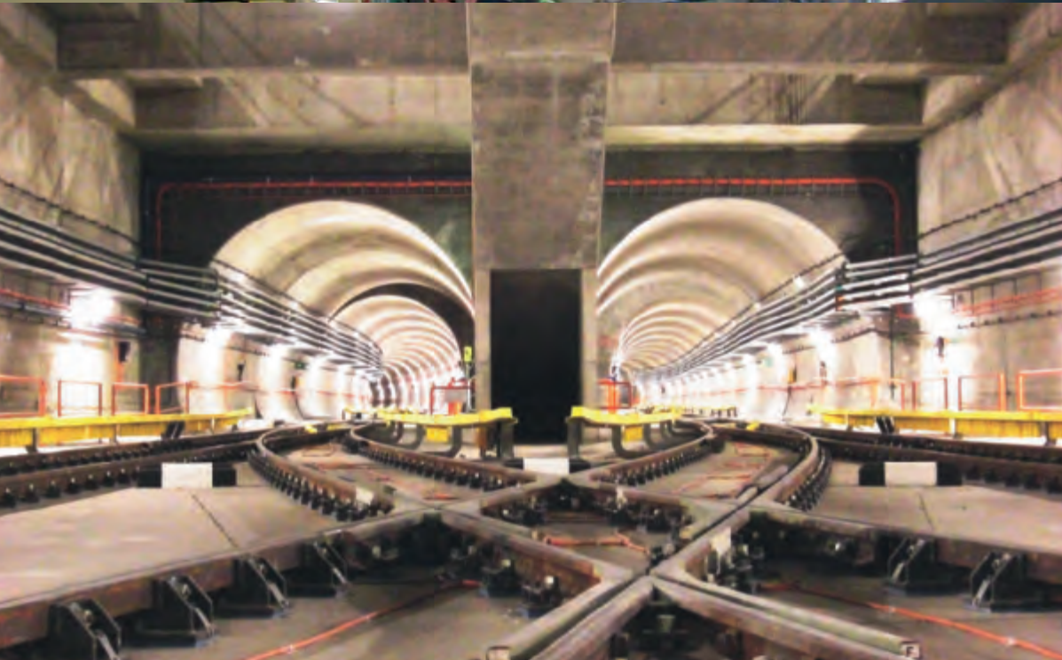
Die Wiener Linien sind ein wichtiger Stammkunde von Elin. Über Jahrzehnte betreut Elin diesen Kunden in allen Be- reichen der Elektrotechnik. Seit 2002 ist die Mittelspan- nungsversorgung der U-Bahn- Linien eines der wichtigsten Projekte
