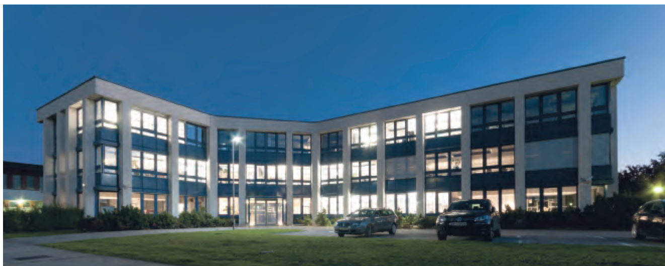
Betriebsgebäude von Elin in Wien
