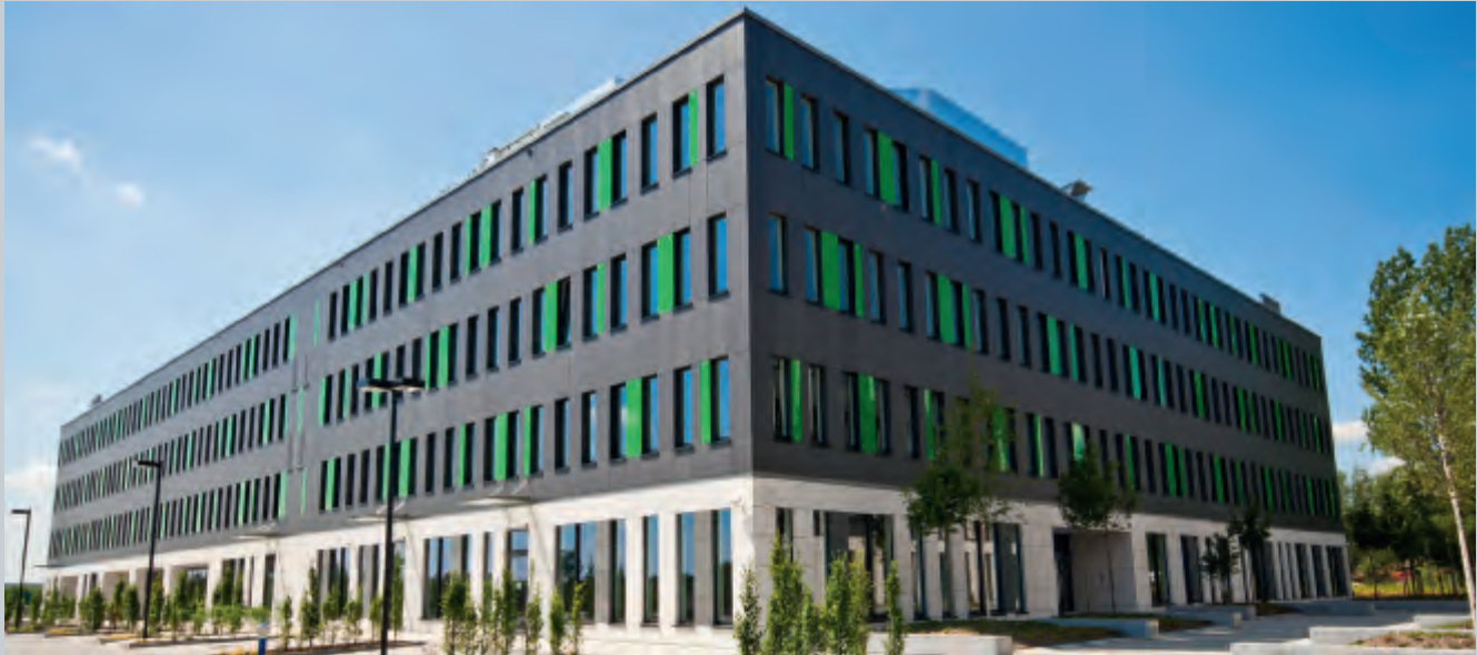
Poleczki Park in Warschau: Ein Projekt der UBM-Realitätenentwicklung. Bürozentrum mit 20 Gebäuden und zirka 260.000 m 2 Nutzfläche; von Porr als GU errichtet, die Haustechnik von HTG-Polska und TKT geplant und ausgeführt
